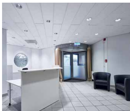
Energieeffiziente Downlight-Leuchten in der Rezeption.
